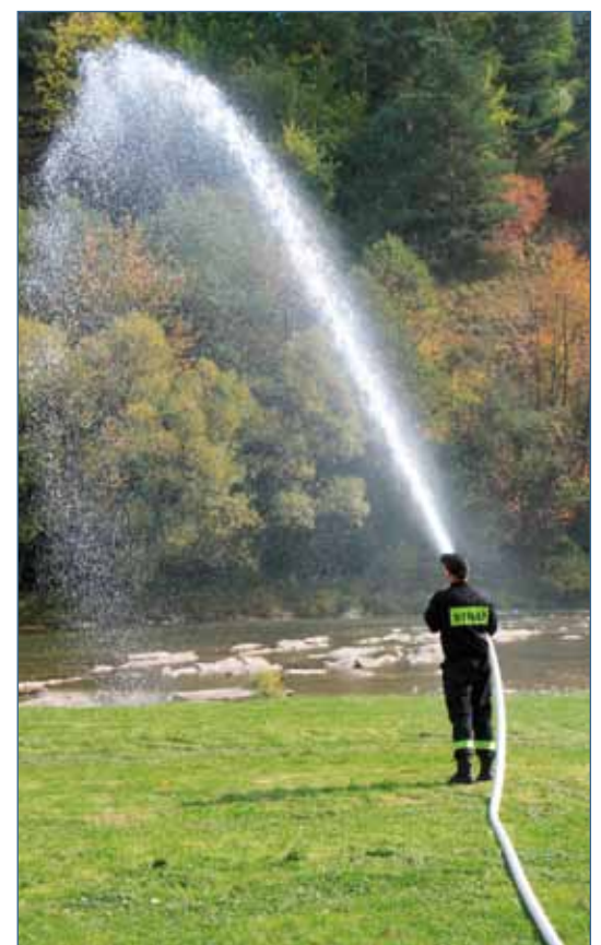
Jak widać oficjalny test nowego wodociągu wypadł pomyślnie.
