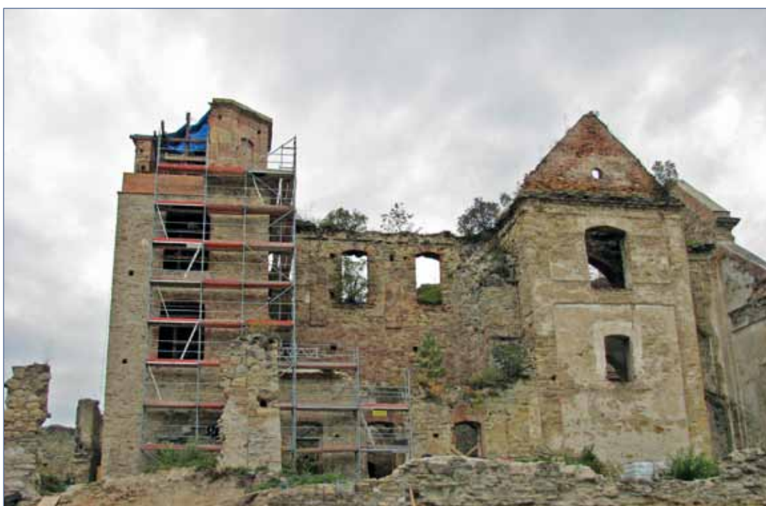
Prace budowlane przy tarasie widokowym na jednej z kościelnych wież.
