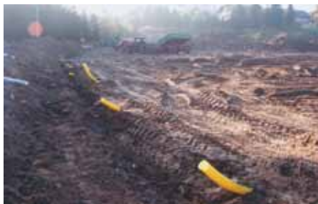
Instalacja rur drenacyjnych na boisku LKS Czaszyna.
